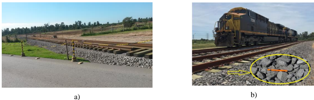
Fig. 7. Ramal ferroviário da CSA construído no Brasil com balastro de escória de aciaria: a) aspecto da construção; b) via em serviço e detalhe do material da camada de balastro.
