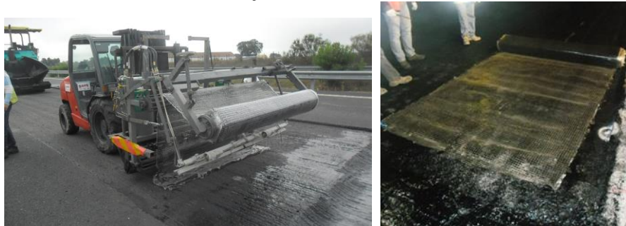
Fig.1. Aplicação mecânica e aplicação manual de grelhas de fibra de vidro e de fibra de carbono
