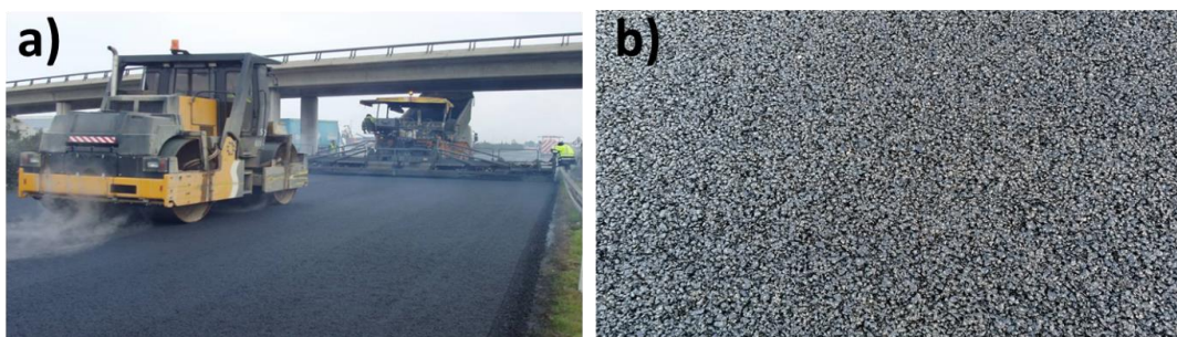
Fig.8. Obra de reabilitação A8
