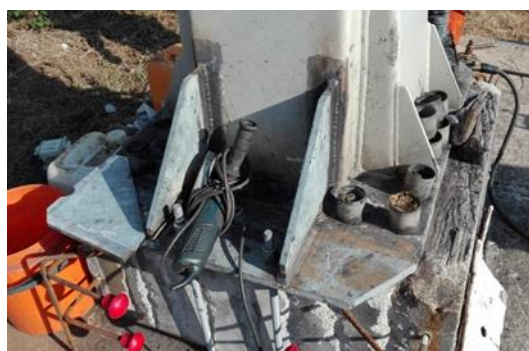
Figura 10. Reforço estrutural executado numa estrutural existente.
