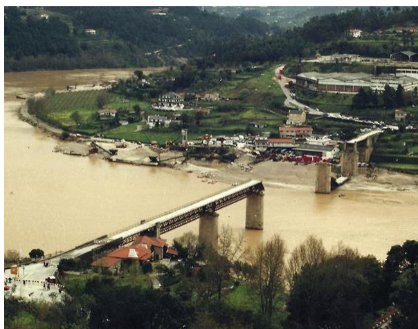
Fig. 1. Ponte de Entre-os-Rios depois do colapso
