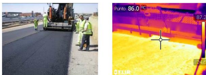
Fig.6. Aplicação de camada intermédia. Termografia da mistura à saída da régua.
