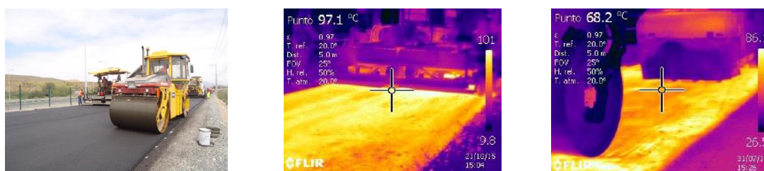
Fig. 9. Controlo termográfico da obra
