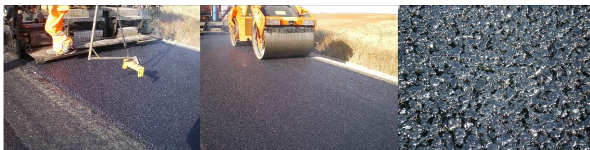
Fig.3. Imagens do espalhamento e compactação de uma mistura SMA-16
