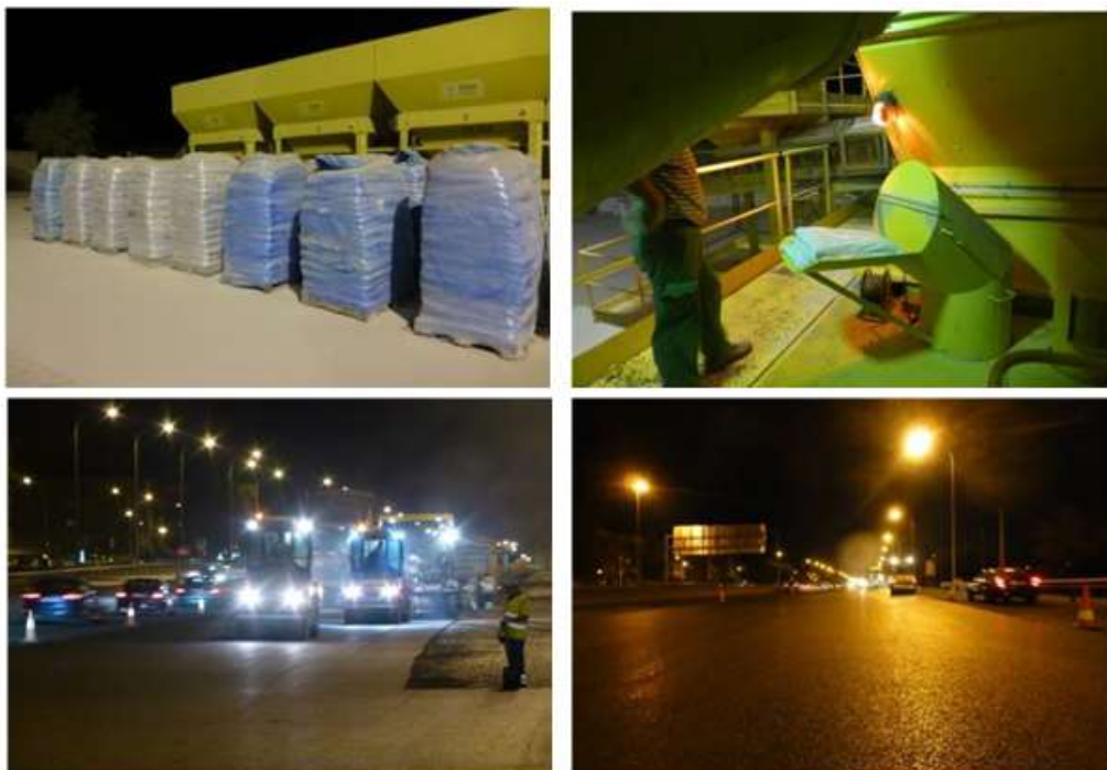
Fig.8. Aplicação de SMA na Autovia A5 (Madrid) em 2014
