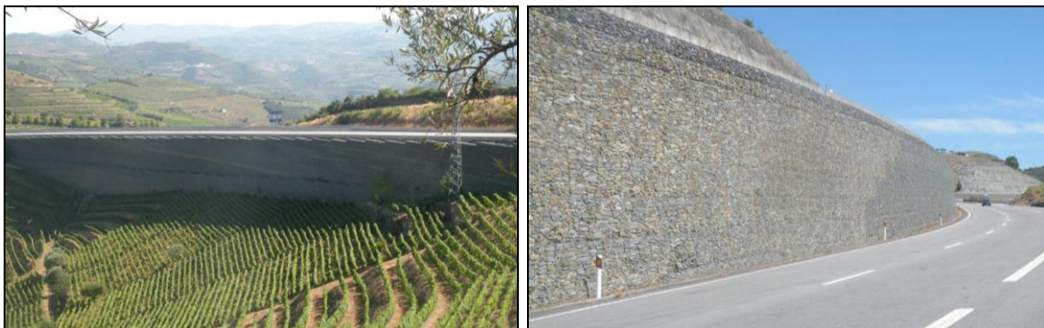
Fig.2. Muros de suporte da A24 (exemplos: muros MAE 862_177 e MC 880_191)
