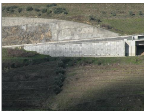
Fig.6. Vista geral do muro MAE 885_201 e área de influência (PK 88+500 da A24)
