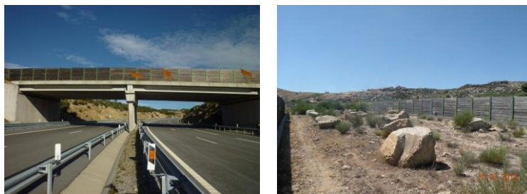
Fig. 3. Passagem superior para lobos existente na A24
