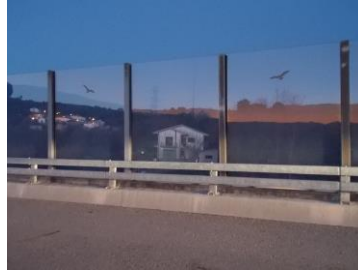
Fig. 4. Sombras de predadores em barreira acústica para espantar voadores, existente na A24
