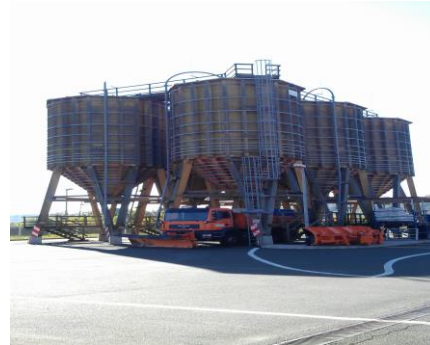
Fig. 12. Armazenamento em Silo
