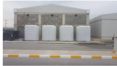
Fig. 10. Estação de salmoura com armazenamento suplementar
