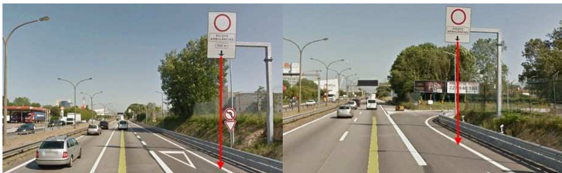
Fig.1. Fase 4 de uma ASR: ausência de correcção da deficiente colocação da sinalização sobre a via a que respeita
