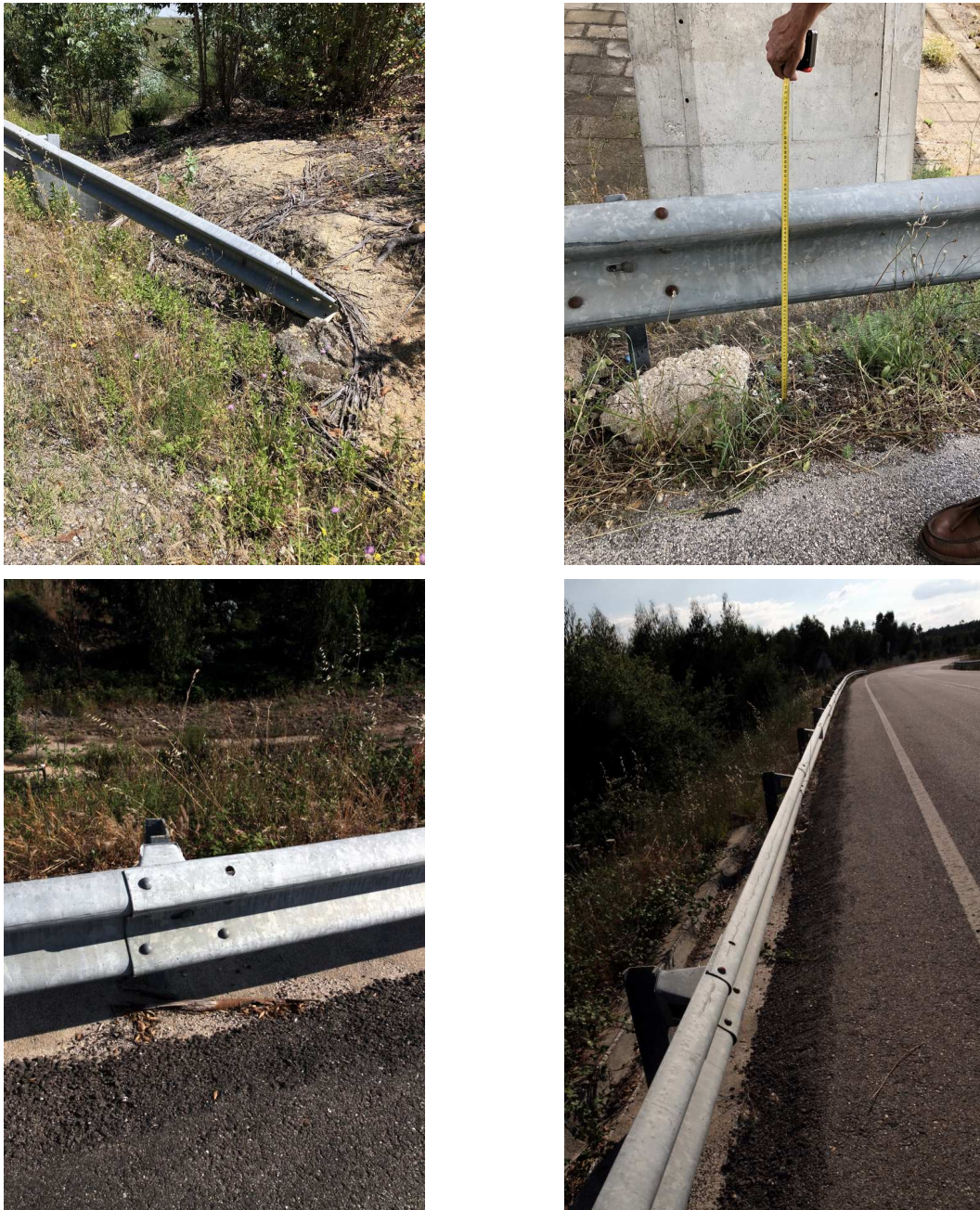
Fig. 2. Fase 4 de uma ASR: risco de agravamento das consequências de despistes por deficiente instalação de barreiras de segurança
