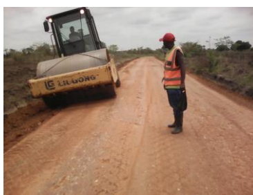
Fig.5. Distrito de Nhamatanda durante as Obras
