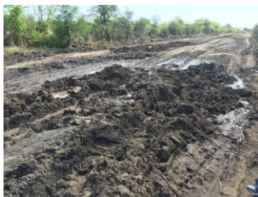
Fig.4. Distrito de Nhamatanda antes das Obras
