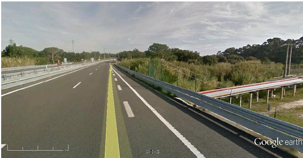
Fig.4. Barreira com nível de retenção N2 em viaduto sobre pipeline (Fonte: Google earth )
