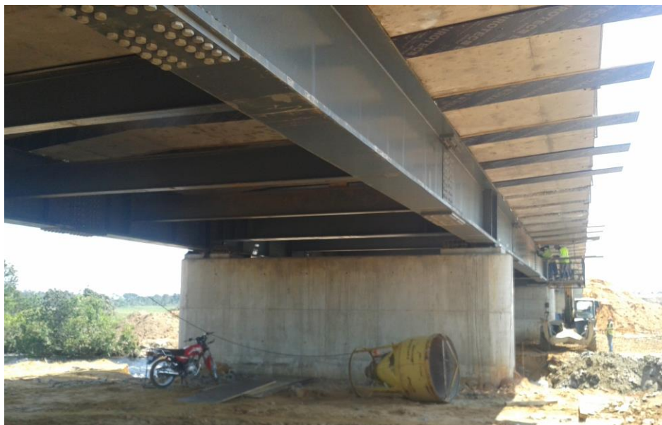
Fig. 7: Execução da Ponte sobre o Rio Caluango.
