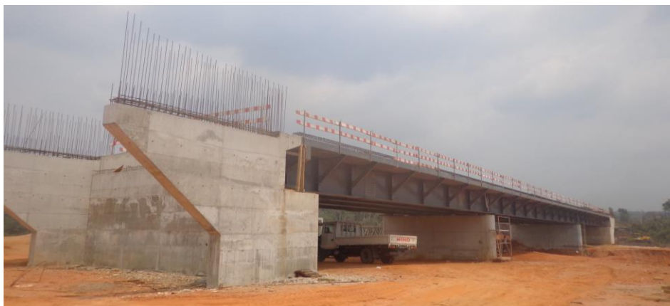
Fig. 4: Execução da Ponte sobre o Rio Luangue.
