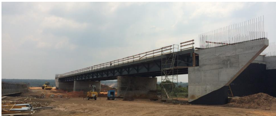
Fig. 3: Execução da Ponte sobre o Rio Cuílo.
