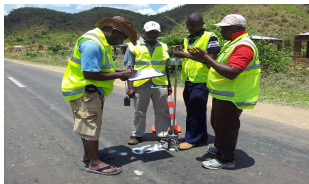
Fig. 2- Ensaios de deflexo usando um defletmetro de peso leve (LWD)
