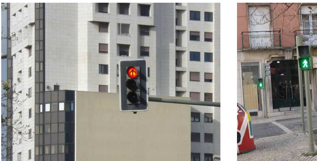
Fig. 2. Exemplo de melhoria da visibilidade dos semáforos com recurso a placa de contraste e fontes LED
