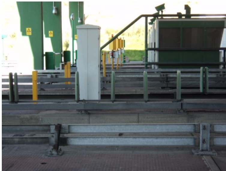
Fig.5. Guardas de Segurança introduzidas, limitando a zona de atravessamento pedonal
