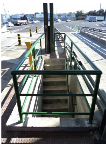
Fig.4. Escada intermédia de acesso ao túnel construída no âmbito do projeto
