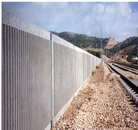
Fig.11. Exemplo de barreira acústica de betão
