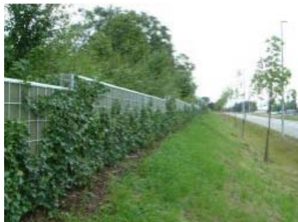
Fig.13. Exemplo de barreira acústica com revestimento vegetal
