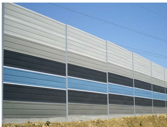
Fig.10. Exemplo de barreira acústica metálica
