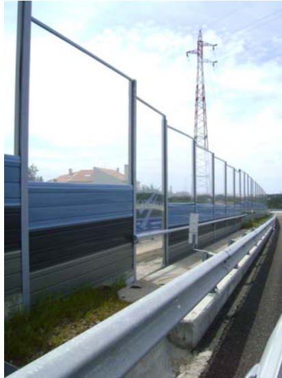
Fig.12. Exemplo de barreira acústica metálica com janela em acrílico
