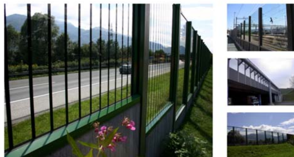
Fig.16. Barreira acústica em acrílico transparente com efeito [13]
