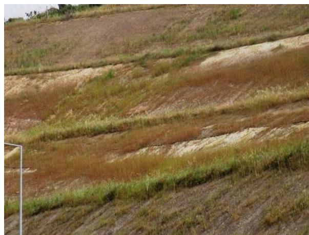
Fig. 3. Panorâmica da hidrossementeira, 2º e 3º panos de talude, maio de 2015
