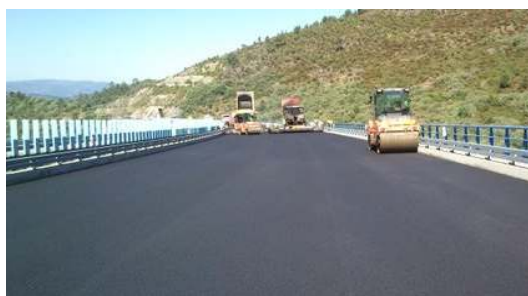
Fig.1. Aplicação da mistura SMA 12 no Viaduto IX do lanço Basto/Ribeira de Pena da autoestrada A7
