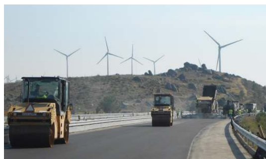
Fig.4. Aplicação da mistura SMA 12 na autoestrada A24
