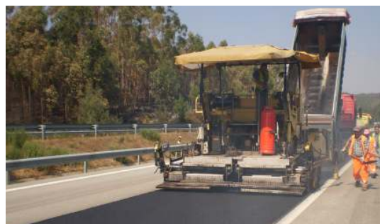
Fig.2. Aplicação da mistura SMA 12 na autoestrada A25
