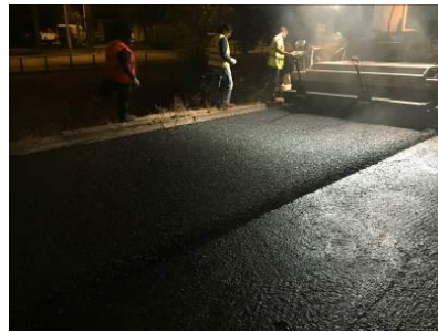
Fig.10. Aplicação do SMA11
