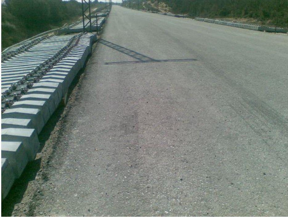
Figura 6. Sub-balastro betuminoso aplicado num dos troços experimentais.
