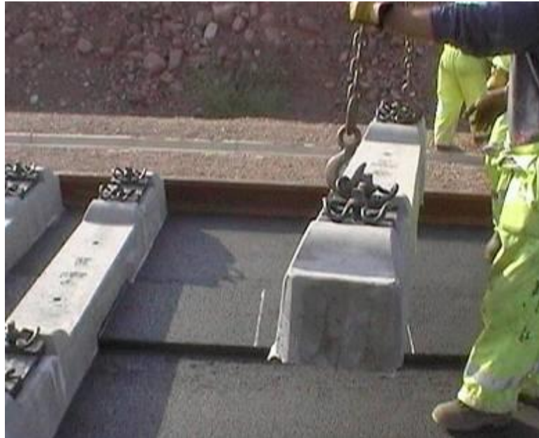
Figura 3. Posicionamento das travessas no sistema ATD.
