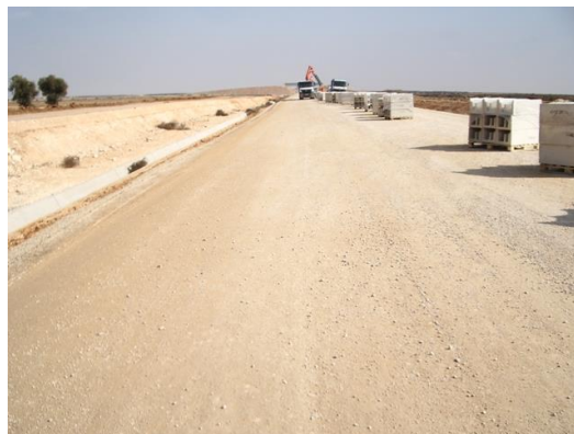
Figura 1. Trabalhos sobre camada de sub-balastro granular.
