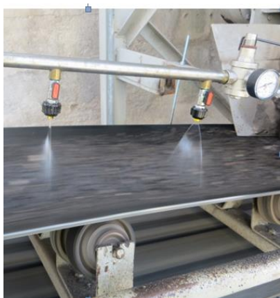
Figura 7 – Tratamento da MBR com aditivo
