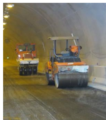
Figura 9 – Compactação em obra
