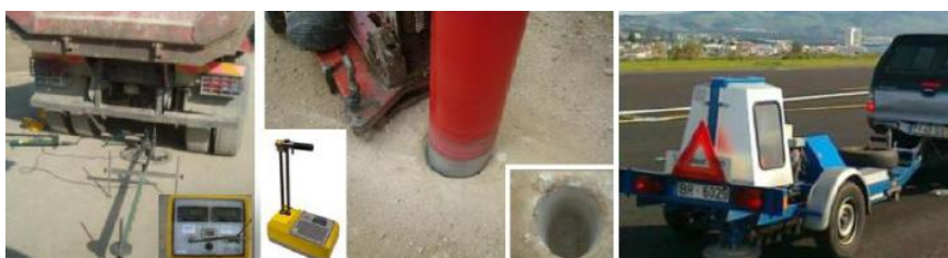
Fig.12. Controlo de qualidade das camadas, durante e após a construção
