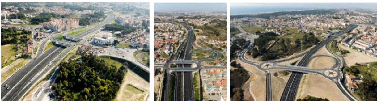
Fig.13. Vista parcial da obra executada no IC 32 - atual A33 (entre o IC20 e o nó de Palhais)
