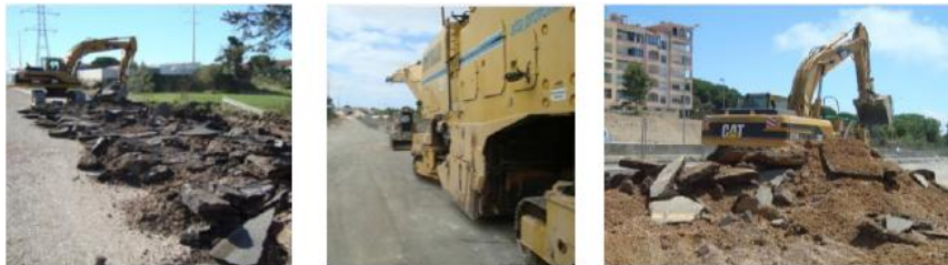
Fig.6. Demolição e remoção dos pavimentos existentes com escavadoras e fresadoras
