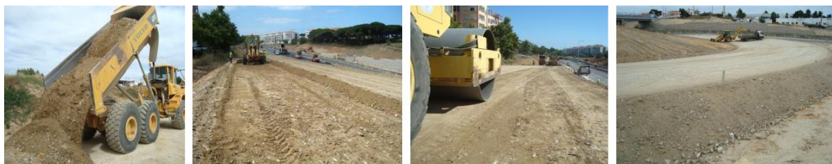
Fig.10. Aplicação tradicional de um dos eco-Agregados (SAR)
