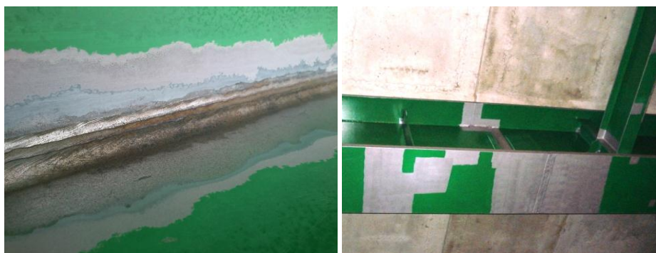
Fig.15. aspecto dos trabalhos de reparação da pintura
