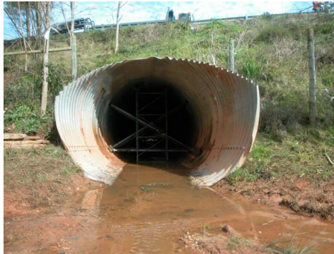
Fig.9. Vista da boca de jusante da obra
