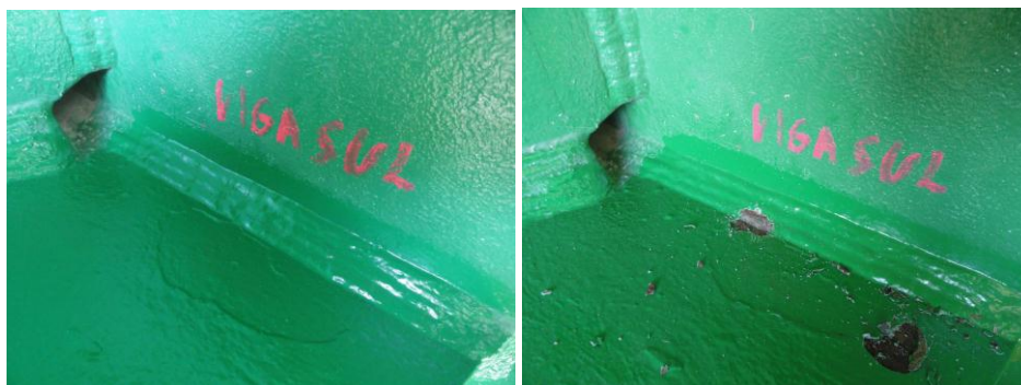
Fig.14. aspecto de anomalia no primeiro ensaio de reparação da pintura
