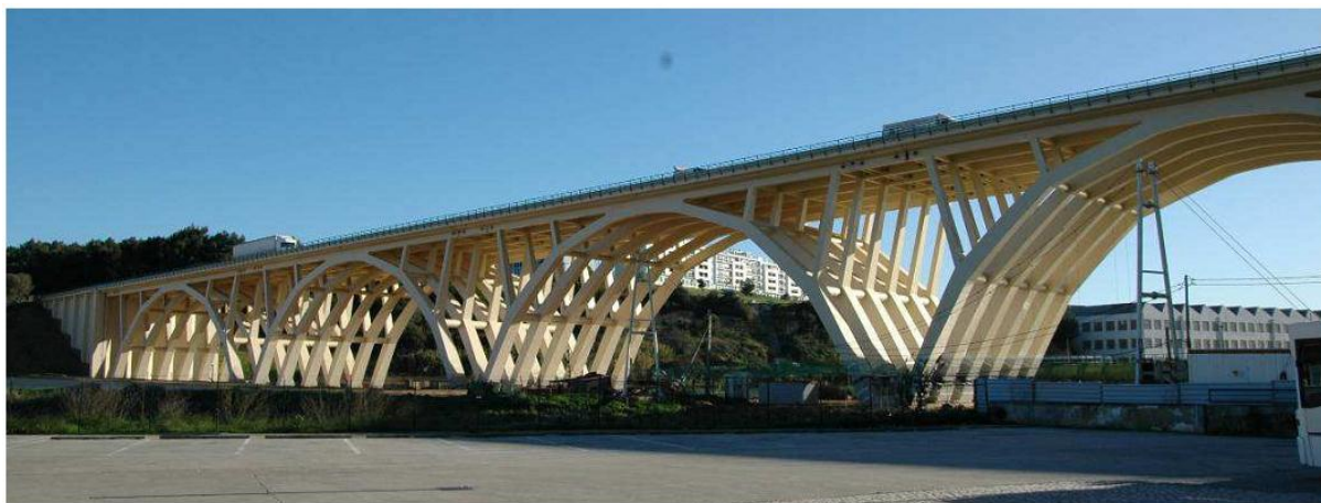
Fig.1. Vista geral da Obra
