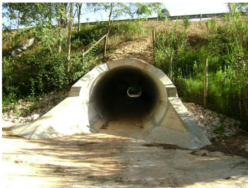
Fig.11. Aspecto final da obra reparada e reabilitada
