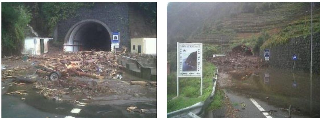
Fig.11. Danos decorrentes do Temporal de 5 de Novembro de 2012
