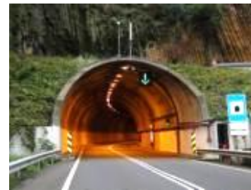
Crescimento de vegetação nos emboquilhamentos
