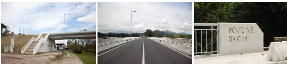
Fig. 11 Vistas finais da obra após a intervenção de reparação e reforço estrutural.
