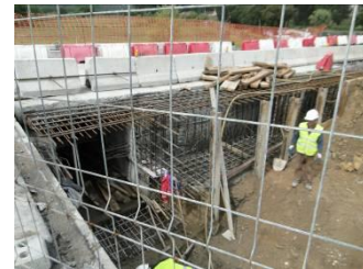
Fig. 2 Intervenção no tardoz do Encontro Direito: a) Excerto de Projecto, com corte Transversal; b) Foto com Solução durante a fase de construção;
