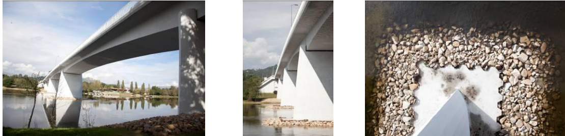
Fig. 10 Vistas gerais da obra; Pormenor do tapete de enrocamento.
