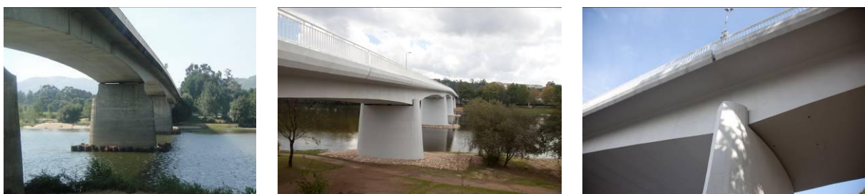
Fig. 7 Vista da Ponte antes de Intervenção; Vista da Ponte após Intervenção; Pormenor do Batente.
