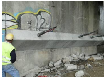
Fig. 3 Corte longitudinal do maciço; Pormenor da viga de reforço fase de construção; Aspecto final.
