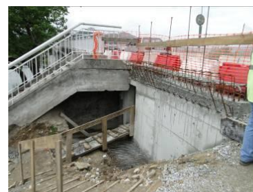
Fig. 9 Intervenção no tardoz do Encontro Esquerdo: a) Excerto de Projecto, com corte Transversal; b) Foto com Solução durante a fase de construção;
