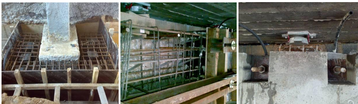
Fig.13. Pormenor do maciço de encabeçamento das colunas de jet-grout; pormenores de execução da nova “mesa”.
