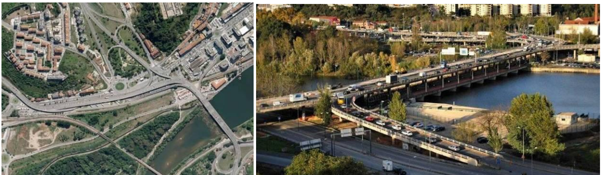
Fig.1. Vista aérea de toda a extensão da obra de arte e vista geral da Ponte Açude.
