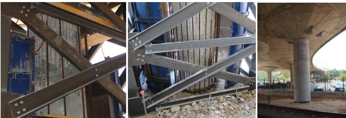
Fig.11. Suspensão do tabuleiro e reposição do monolitismo da secção; pormenor da selagem de varões na base do pilar; pilar após intervenção.
