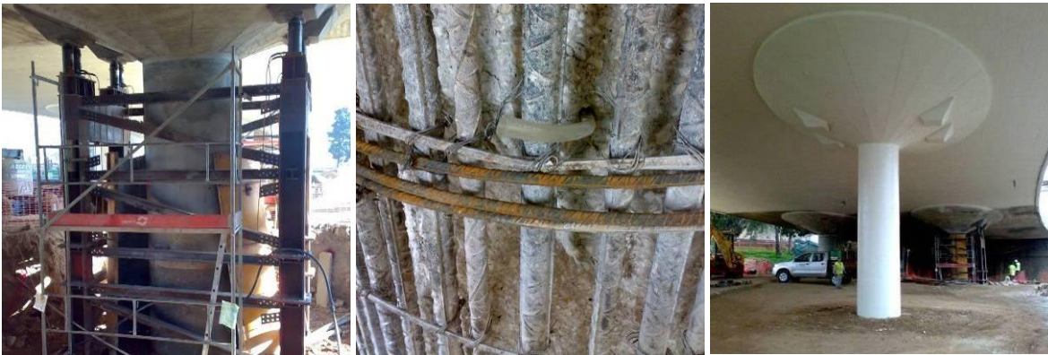
Fig.10. Suspensão do tabuleiro; remoção do recobrimento, colocação de injectores e da armadura de cintagem complementar; pilar após intervenção.
