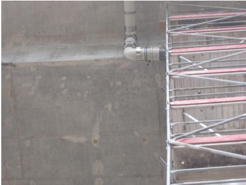
Fig.3. Pormenor da junta de dilatação na tubagem DN 300 junto ao pilar P 9
