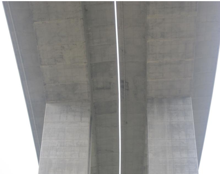
Fig.2. Tubagem em FFC instalada sob os dois tabuleiros do Viaduto do Loureiro
