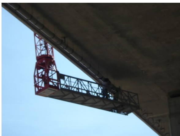
Fig.7. Equipamento “By-Bridge” a instalar a tubagem metálica debaixo do tabuleiro
