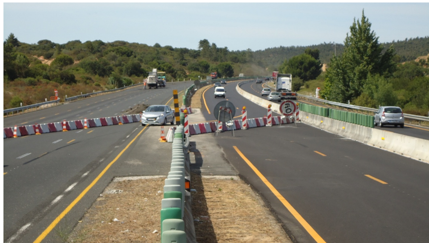
Fig.2. Foto da Zona Final do Basculamento
