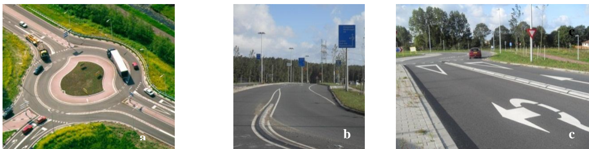
Fig.3. Turborotunda: (a) imagem de uma turborotunda; (b) e (c) pormenor da delimitação das vias na entrada e saída (Leiden, Holanda)
