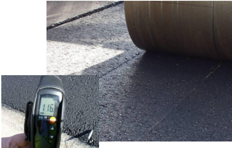
Figura 3. Detalhe da compactação da mistura
