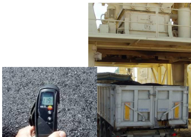
Figura 4. Detalhe do fabrico da mistura
