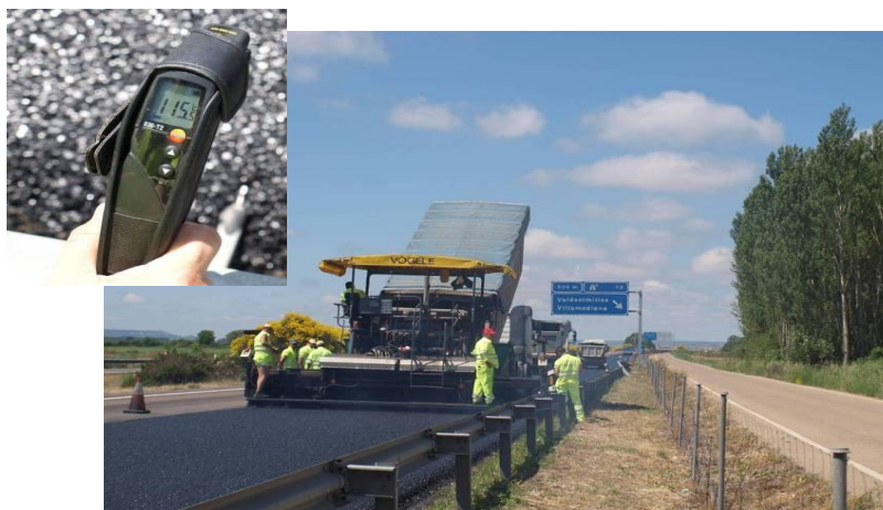
Figura 5. Detalhe do espalhamento da mistura
