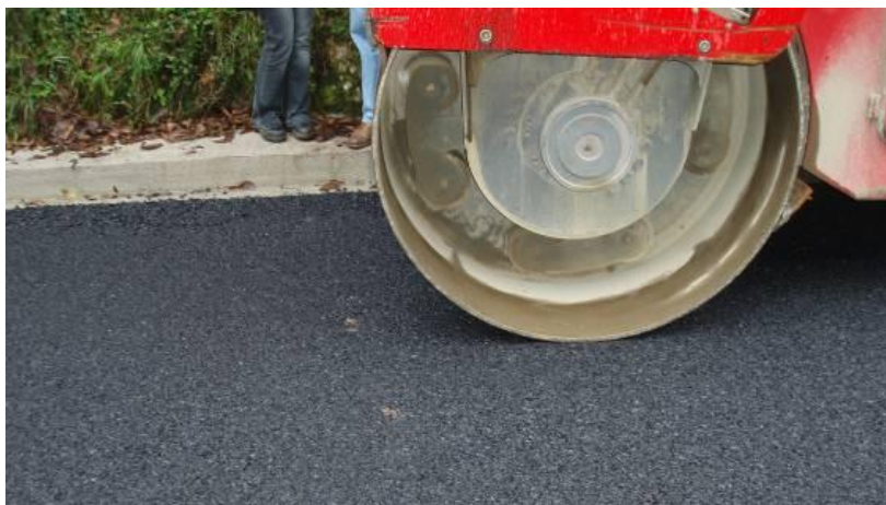
Figura 2. Detalhe da compactação da mistura
