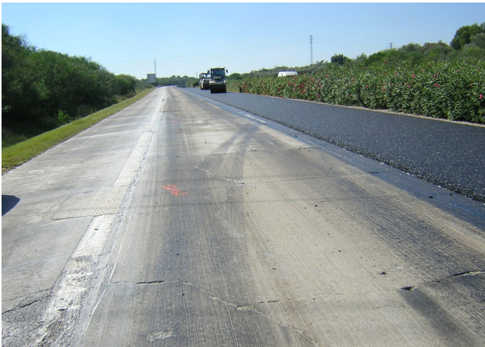
Fig.1 Aplicação anti fissuras
