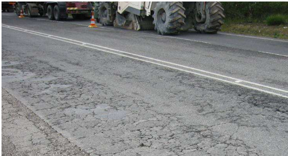
Figura 2 – Aspecto da superfície do pavimento existente antes da obra de reabilitação
