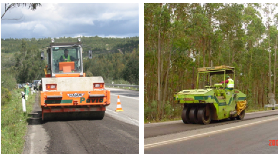
Figura 4 – Compactação da camada reciclada
