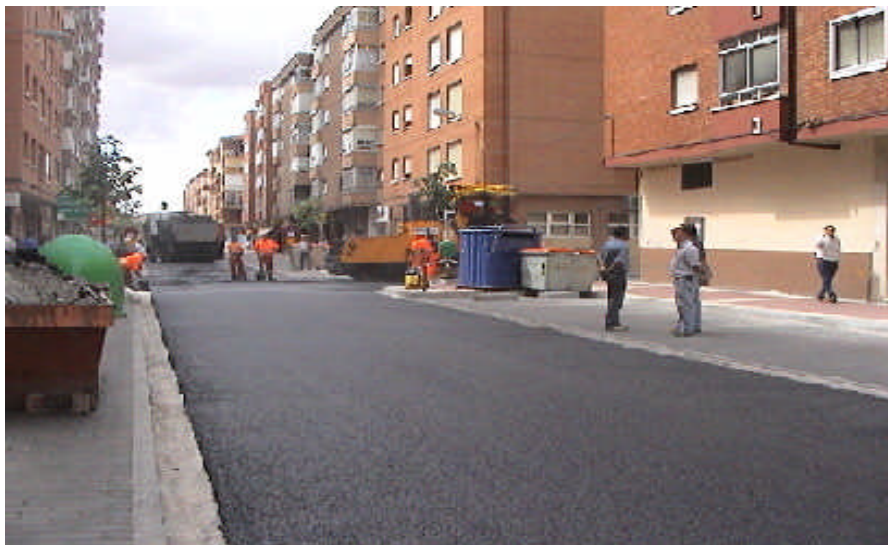
Foto 5. Una calle en Valladolid pavimentada con mezclas bituminosas de alto contenido de caucho. Los pavimentos urbanos, con capas tratadas con cemento, son ideales para cubrir con estas mezclas bituminosas que retrasan la aparición de fisuras reflejadas.
