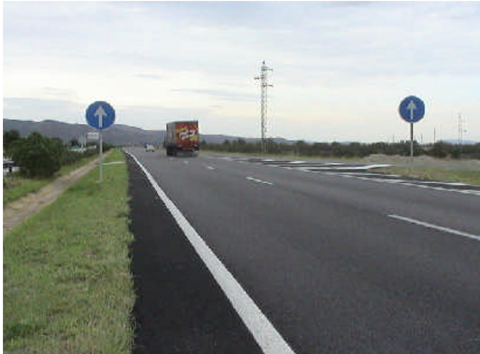
Foto 3. Aspecto de la Autopista AP-7 un año después del recrecimiento con mezclas de alto contenido de caucho.
