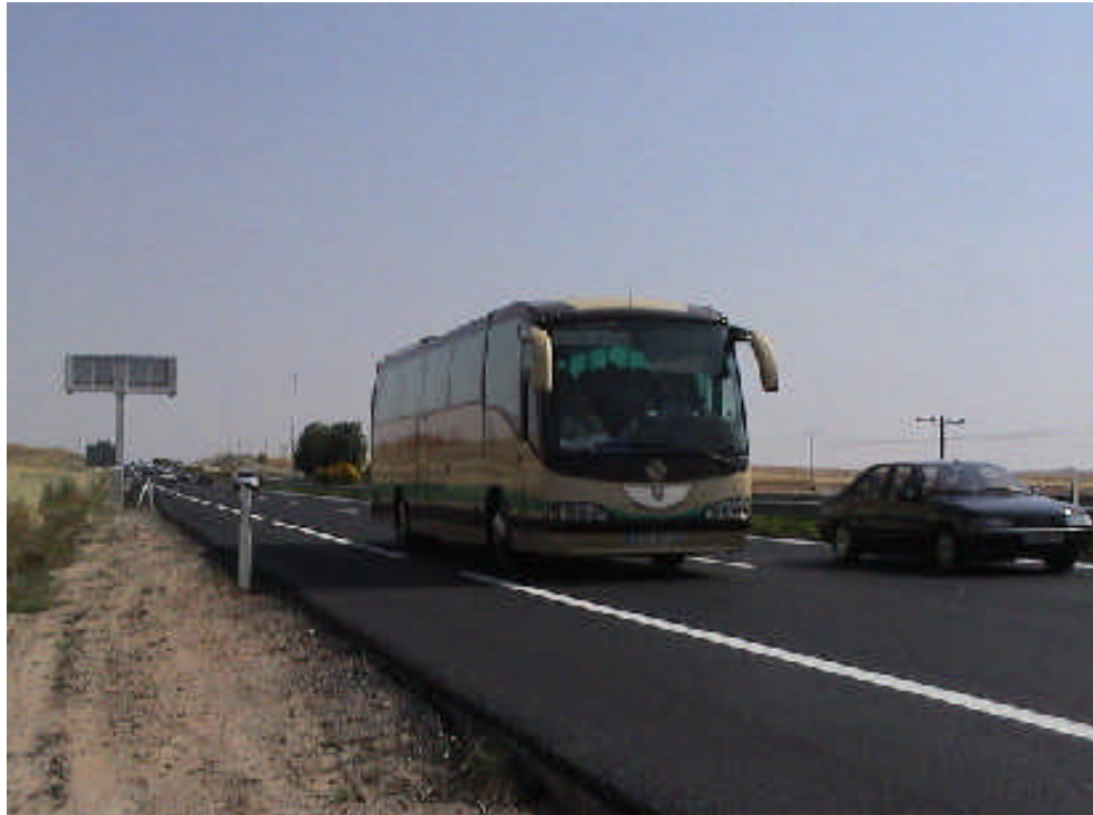
Foto 7. Autovía N-IV. Aspecto del recrecimiento de un pavimento rígido con mezclas bituminosas de alto contenido de caucho.
