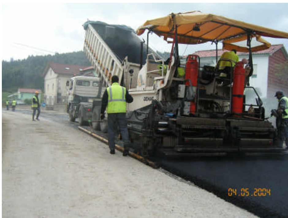
Foto 4. Ctra. Revilla – Puente Arce. Actuación sobre un firme reciclado con cemento "in situ". Cantabria.
