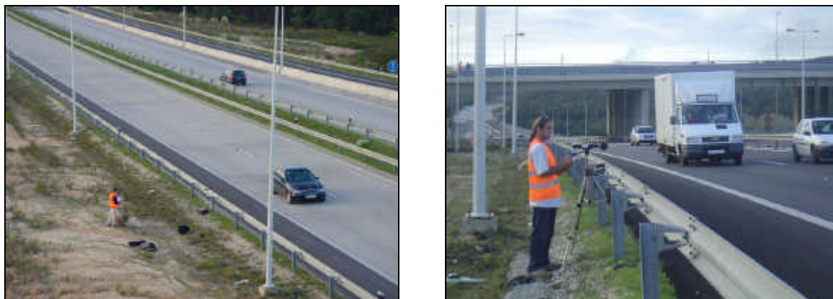
Figura 6 –Pormenores da medição de níveis sonoros no pavimento BAC e no BMB (4º e 5º ensaios)
