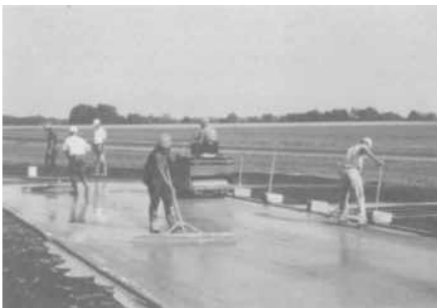
Figura 2 – Aplicação da calda de cimento na camada porosa
